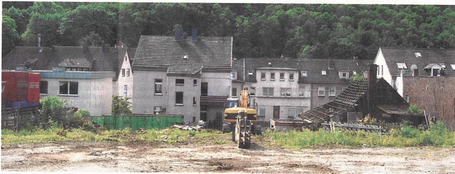
Für den Neubau eines Bürogebäudes der Winner-Spedition werden die Häuser Brinkhofstraße 39 (li.) und 37 (mitte) sowie die angrenzende ehemalige Schmiede abgerissen. Das Foto entstand an der Wiesenstraße, der Abrissbagger wird sich vor dort zur Vorderfront „durcharbeiten“.
